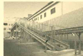
新凍結庫への搬送ライン
