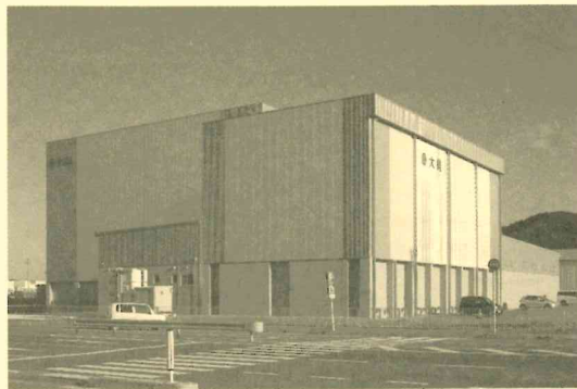
新設冷凍冷蔵庫
