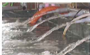
・浄化、保管用水槽
