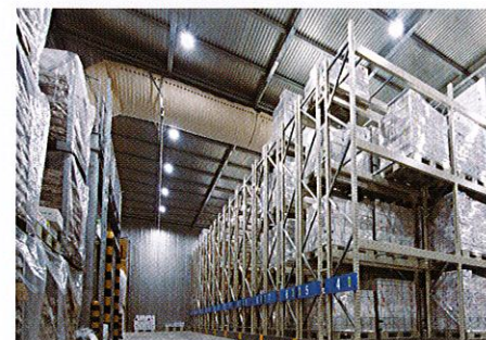
営業冷蔵倉庫内（大槌工場）
