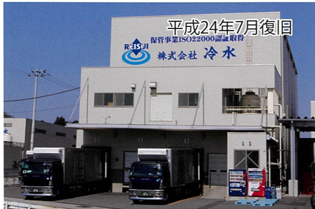
本社 立体自動・地下冷蔵庫
