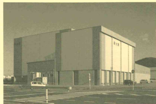
新設冷凍冷蔵庫
