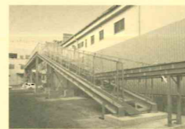
新凍結庫への搬送ライン
